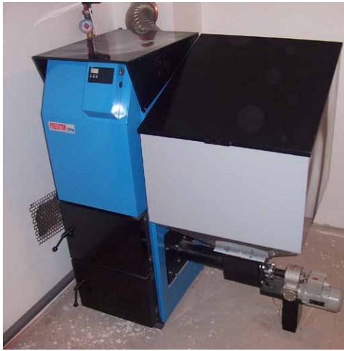
Автоматический водогрейный котёл PELLETIA – Ling 25
